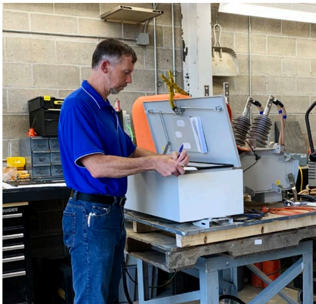
Doug Barab trong xưởng thí nghiệm bên cạnh một Recloser OSM và tủ điều khiển RC-10.
